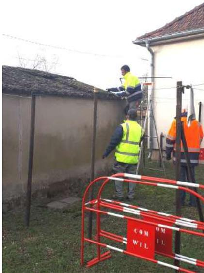
Démontage de la toiture du vieux garage du presbytère. Les plaques d'Eternite sont entreposées dans des emballages spéciaux afin d'être transportées dans un centre spécialisé de décontamination et de reconditionnement.
