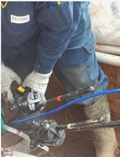
Problème malheureusement récurrent : les anciennes boîtes de jonctions électriques perdent leur étanchéité en vieillissant.
