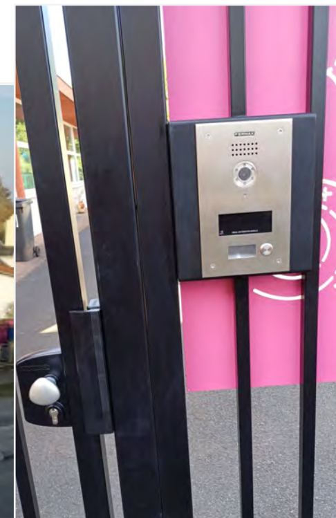
Mise en sécurité de la cour de l'école primaire avec installation de la nouvelle clôture vigipirate et des portails munis de gâche électrique.
