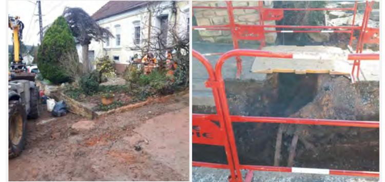
Dépose de revêtements de sol pour tranchées de raccordement chez les riverains
