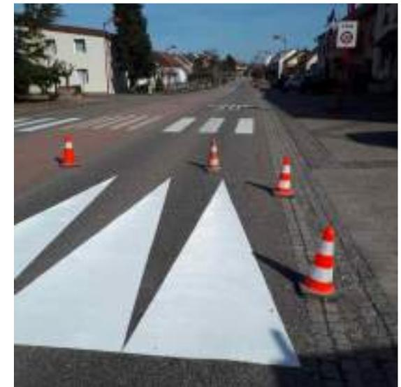
Mise en peinture des dents de requin sur la chaussée afin de renforcer la visibilité du début de la zone 30.
